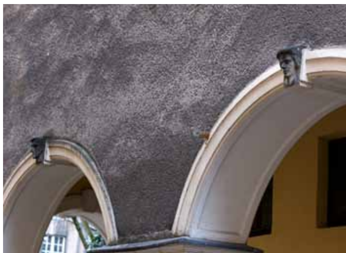
Kamienica, ul. Chlebnicka 20
